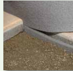
vdw 884 FugenBand 10 mm tief abtrennen
