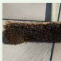
Besen öfter ausspülen – somit nimmt dieser mehr Mörtelreste von der Oberfläche auf und erleichtert die Reinigung
