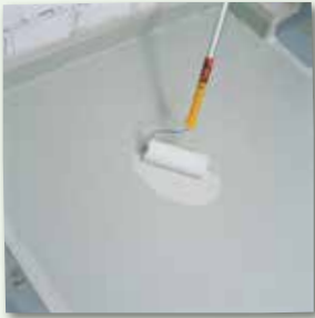
... und mit Fellrolle verteilen
