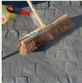
Erhärten des Mörtels auf der Oberfläche vermeiden
