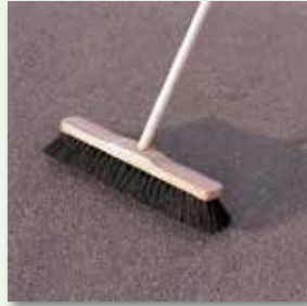
Untergrund sorgfältig vorbereiten
