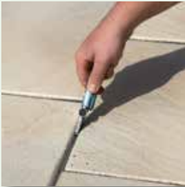
Hierzu Schnittkante FugenBand einkerben
