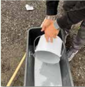
Material entweder in großflächiges Gebinde umtopfen und applizieren, oder auf der Fläche vorverteilen
