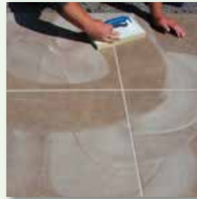
Diagonal zur Fuge abreinigen
