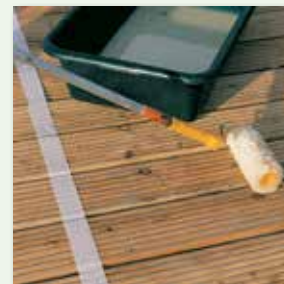
Mittels Fellrolle verteilen
