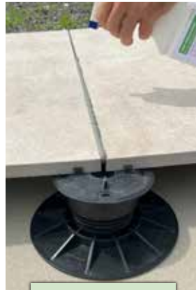
vdw Glättmittel auftragen
