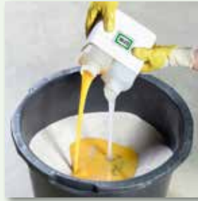
Die beiden Bindemittelkomponenten zumischen
