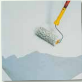
Die 2. Applikation frühestens nach ca. 12 Stunden auftragen
