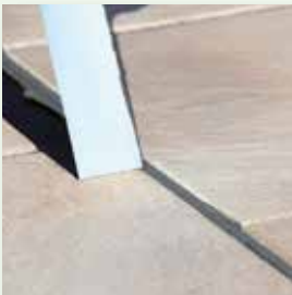
Klebebänder direkt im Anschluss entfernen
