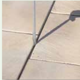
Fugenbandreste komplett entfernen
