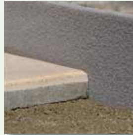
Anschließend den Belag druckfrei verlegen
