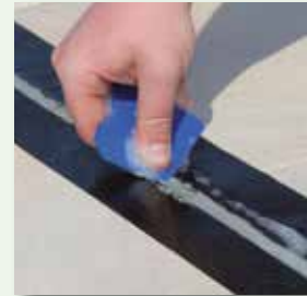
Fugenmasse verdichten und abziehen
