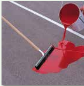
Material vollständig ausbringen und mit Gummischieber verteilen
