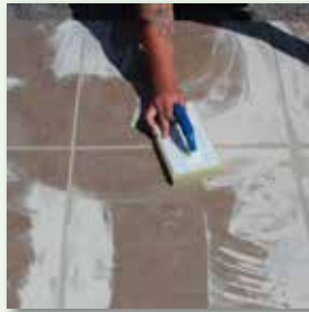
Erhärten des Mörtels auf der Oberfläche vermeiden
