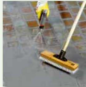
diagonal zur Fuge abreinigen
