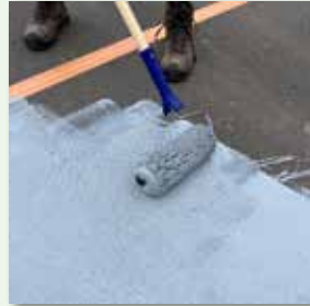
Mittels Malerrolle Material gleichmäßig aufrollen und verteilen.
