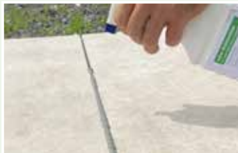
vdw Glättmittel auftragen
