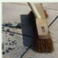
Besen öfter ausspülen – somit nimmt dieser mehr Mörtelreste von der Oberfläche auf und erleichtert die Reinigung
