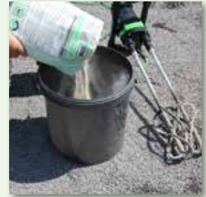
Fugenmörtel zumischen/ Reifezeit beachten
