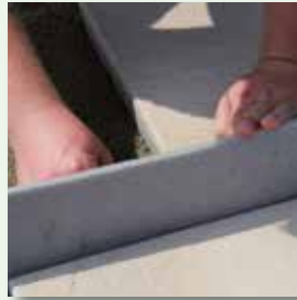
vdw 884 FugenBand im Bettungsmörtel einbringen
