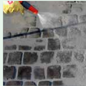
diagonal zur Fuge abreinigen
