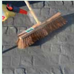
Erhärten des Mörtels auf der Oberfläche vermeiden
