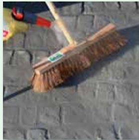
Erhärten des Mörtels auf der Oberfläche vermeiden
