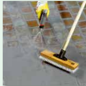
diagonal zur Fuge abreinigen
