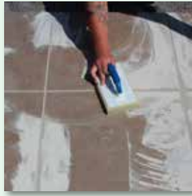
Erhärten des Mörtels auf der Oberfläche vermeiden
