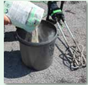
Fugenmörtel zumischen/ Reifezeit beachten
