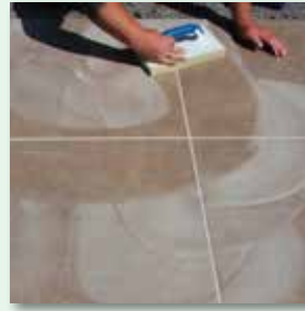
Diagonal zur Fuge abreinigen
