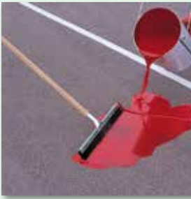
Material vollständig ausbringen und mit Gummischieber verteilen
