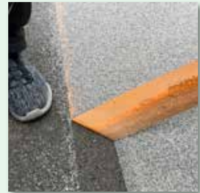
Klebeband vor Erhärtung vorsichtig entfernen und Nachbehandlung beachten.
