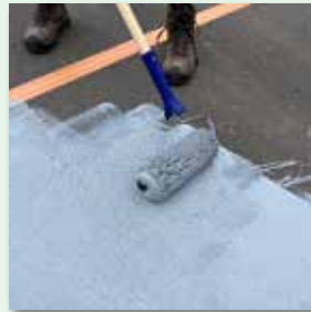
Mittels Malerrolle Material gleichmäßig aufrollen und verteilen.
