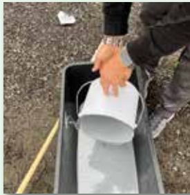
Material entweder Umtopfen in großflächigem Gebinde und applizieren oder auf der Fläche vorverteilen
