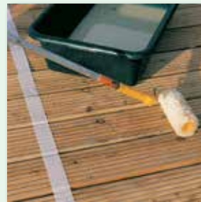
Mittels Fellrolle verteilen
