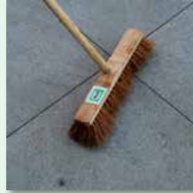
... und feuchtem Besen abreinigen
