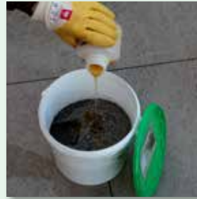
Bindemittelkomponente zugeben
