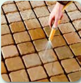
Fläche rückstandsfrei reinigen und vornässen
