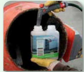
max. 1 l Wasser hinzufügen und homogen anmischen
