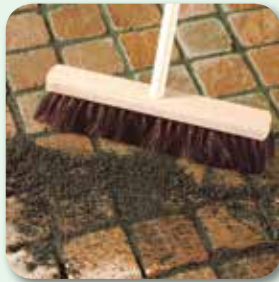
mittels feuchtem Besen abfegen
