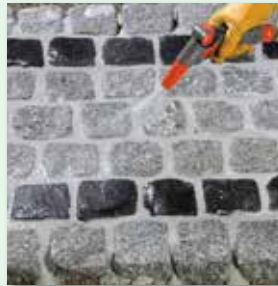
mit Wassersprühstrahl und feuchtem Besen abreinigen
