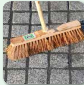
... und feuchtem Besen abreinigen
