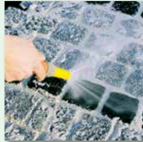
mit Wassersprühstrahl und feuchtem Besen abreinigen
