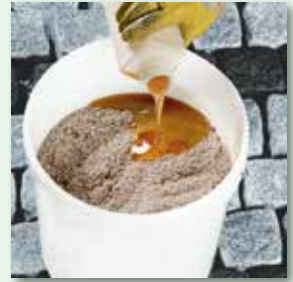
Bindemittelkomponente zugeben
