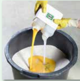
Die beiden Bindemittelkomponenten zumischen
